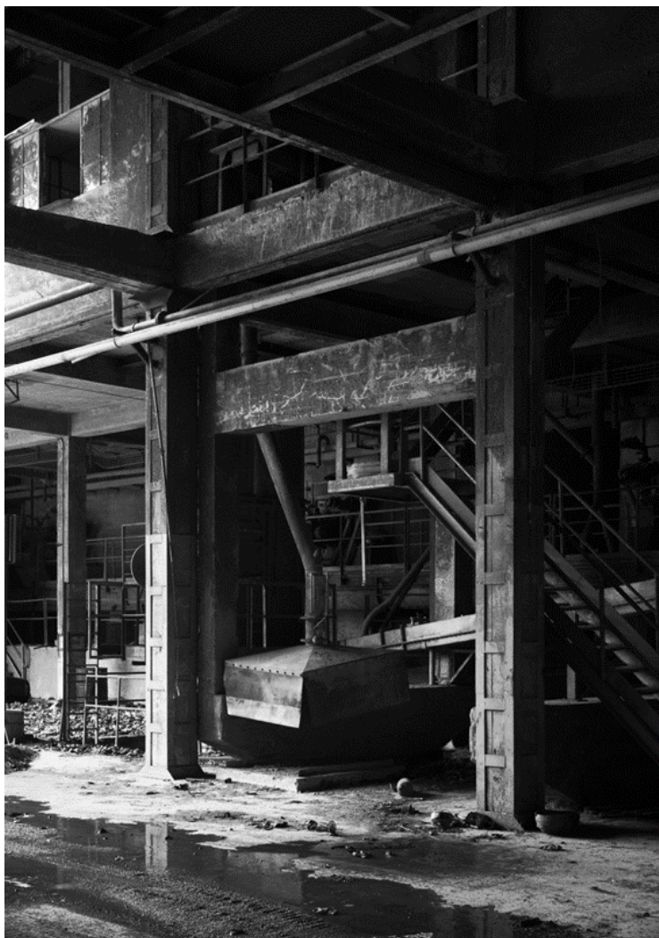
Fig. 2. Cementificio Adriatico stato di abbandono prima della dismissione. (2024).
