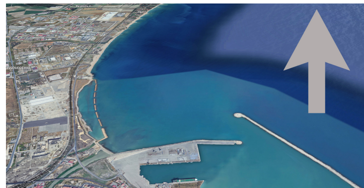
Fig. 4. Porto e area industriale di Crotone (vista aerea, nord). Fonte: Elaborazione su immagine satellitare Google Earth Pro, 2024. Coordinate: 39.08° N, 17.13° E. Tipologia: ortofoto con indicazione di orientamento.
