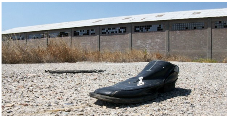
Fig. 3. Basamenti e cordoli di impianto dismesso nell'area ex Pertusola Sud di Crotone. Fonte: Revolweb. (2010). Le industrie abbandonate di Crotone - Ghost factory in south of Italy [Fotografia]. Wikimedia Commons (licenza CC BY-SA 3.0). Coordinate: 39.10° N, 17.13° E. Tipologia: fotografia di campo.
