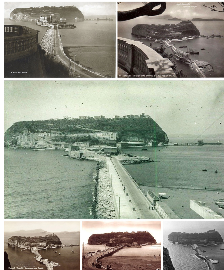
Fig. 12. Fotografie e cartoline storiche descrittive del completamento collegamento della terraferma e della progressiva dismissione delle fabbriche del Lazzeretto di Nisida, 1940-1960 ca.
