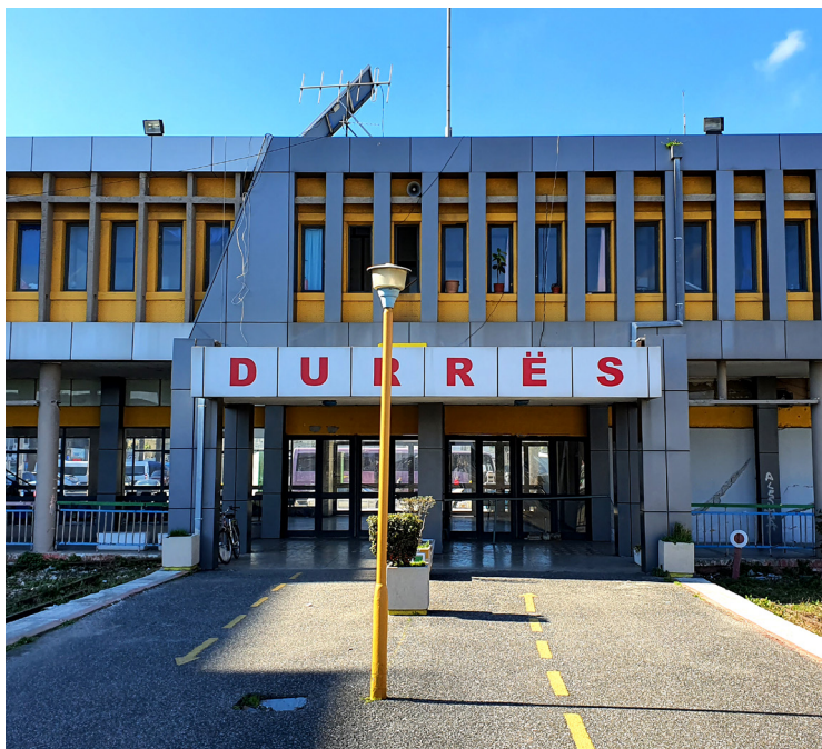
Fig. 3. La stazione ferroviaria di Durazzo. Vista dello stato attuale.
