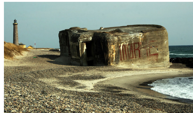
Fig. 3. Bunker tedesco a Grenen, Skagen (Danimarca). Bunker in cemento armato risalente al sistema difensivo tedesco della Seconda guerra mondiale, progressivamente alterato dall'azione del vento e del mare lungo la costa di Skagen, presso il punto di Grenen. Architettura militare ridotta a rovina instabile, in cui il corpo percepisce prima la condizione atmosferica, il rumore e la tensione del paesaggio che la forma costruita. Il bunker diventa così una soglia perturbante tra memoria bellica, processo naturale e paesaggio costiero.
