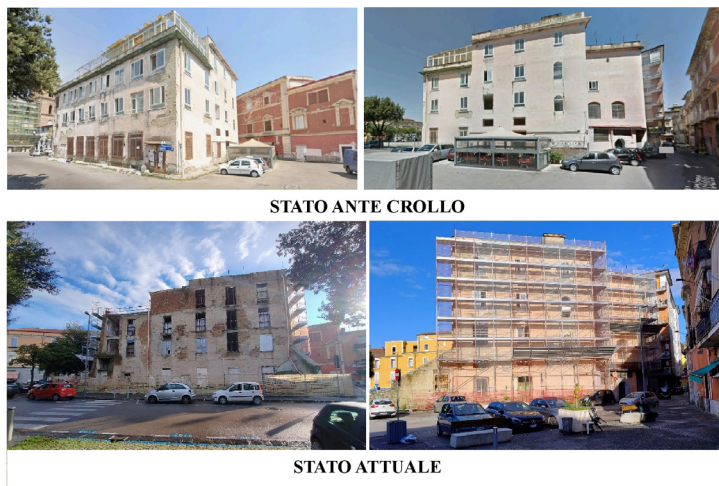
Fig. 4. Foto edificio anni '50. Immagini ante crollo prelevate da Google Maps, stato attuale foto autori.
